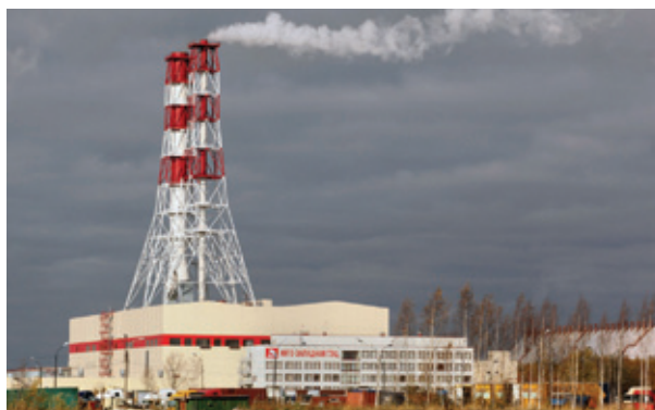
ЮГО-ЗАПАДНАЯ ТЭЦ, г. Санкт-Петербург
